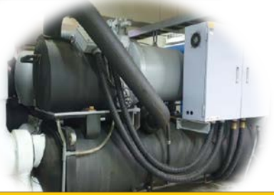
清洗冷凝器銅管
