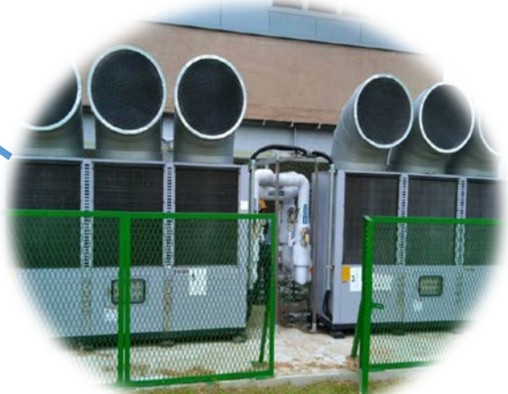
汰換為高效率冰水主機
