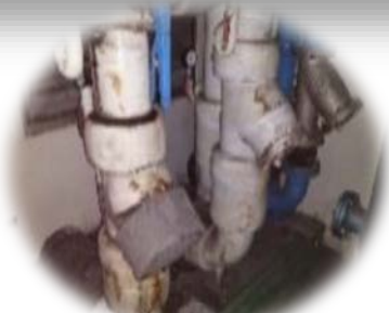
汰換低效率冰水主機
