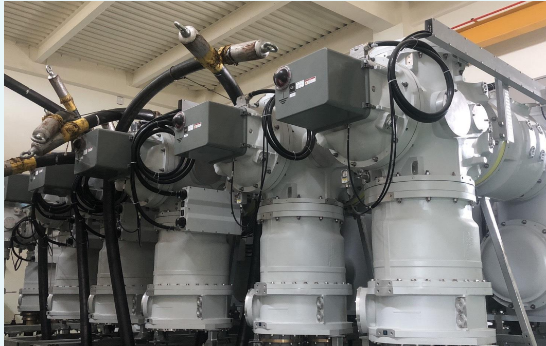
陸上電氣室GIS室電纜整線作業
