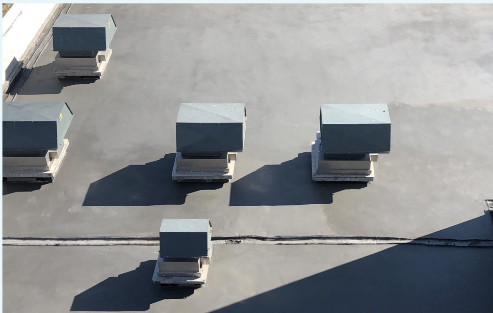
電氣室3F南側屋頂壓層澆置
