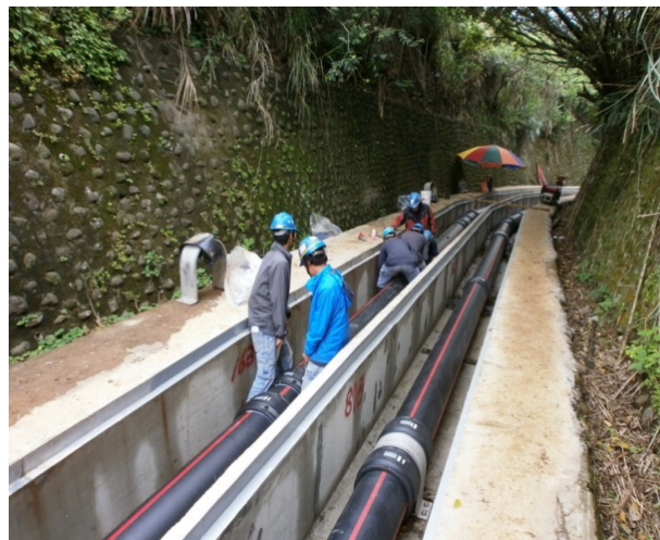
(A) 管溝段 A 管線安裝
