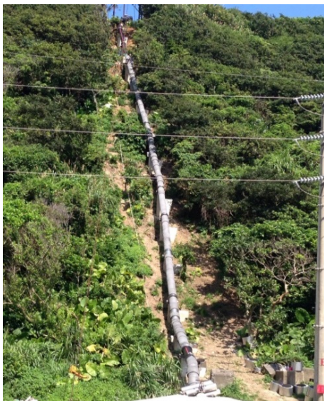
(B) C 管線安裝完成
