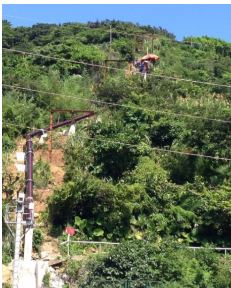
(A) B 管線安裝完成
