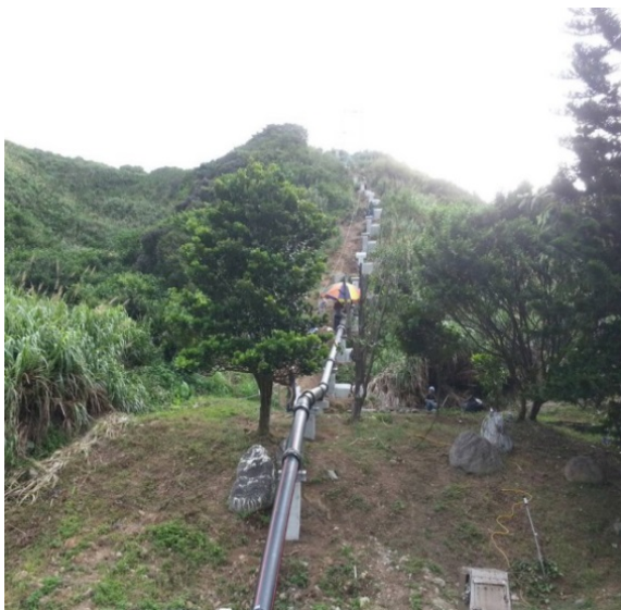
(C) D 管線安裝完成
