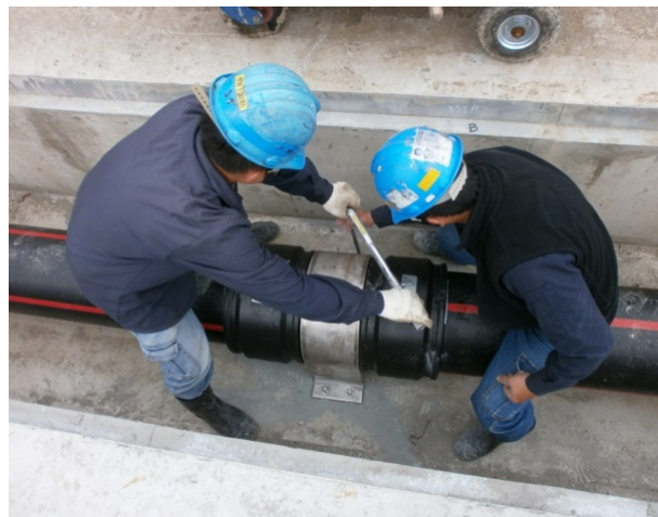
(B) 管線支撐座固定
