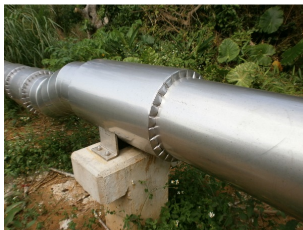
圖 8 HDPE 管線絕熱包覆施工
