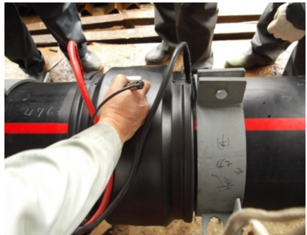
圖 5 掃描條碼通電熔接
