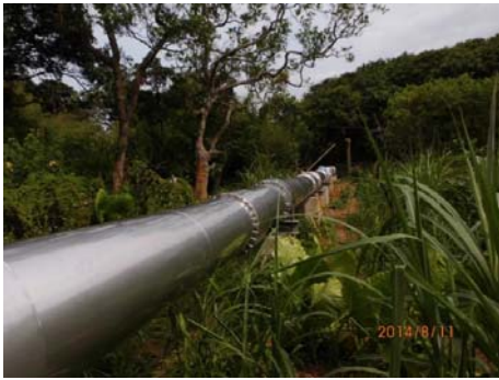
(A) HDPE 管線絕熱包覆完成
