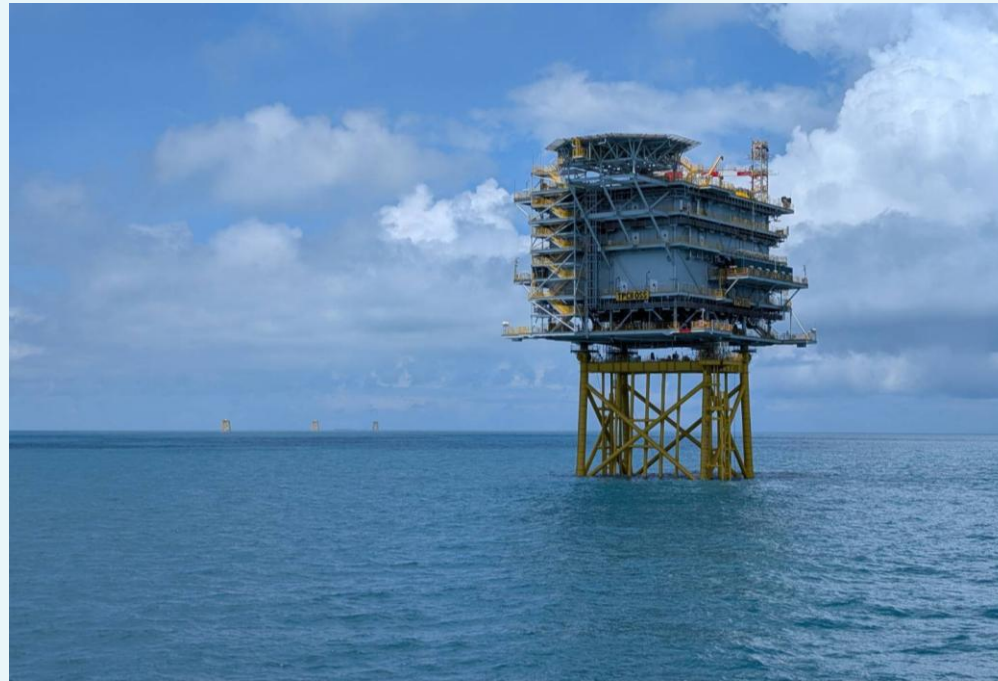
海上變電站安裝作業
