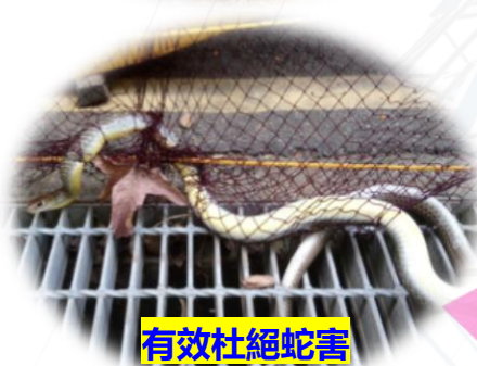
輸電鐵塔蛇網設置
