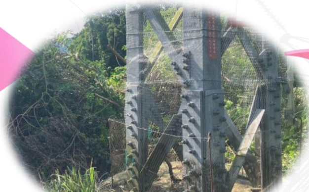
輸電鐵塔蛇網設置
