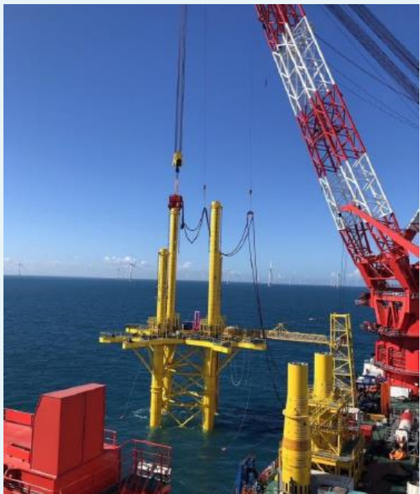
打樁模架吊裝與樁腳打設
