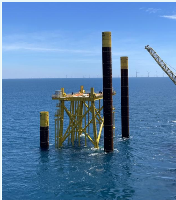
海上變電站下部結構安裝
