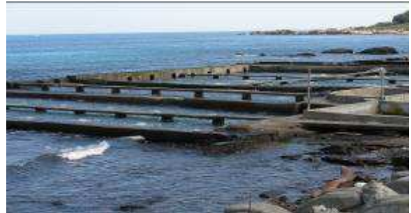
龍洞九孔養殖池
