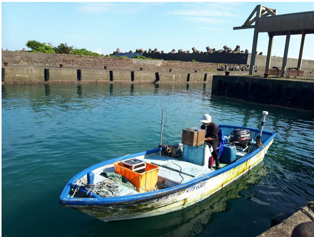
圖 3-7 水深測量實際作業圖
