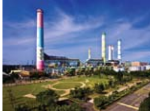
通霄火力發電廠
