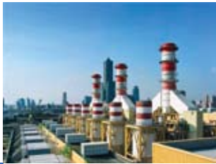
南部火力發電廠
