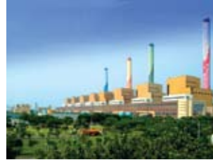
台中火力發電廠
