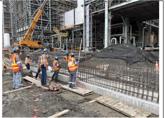
主發電設備工程 廠房結構
