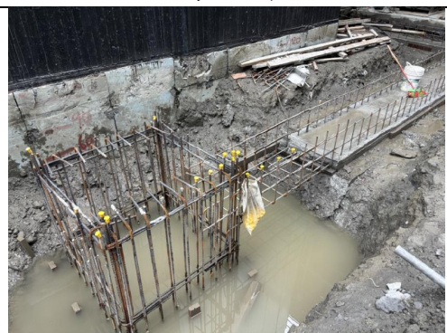
主發電設備工程 排水系統
