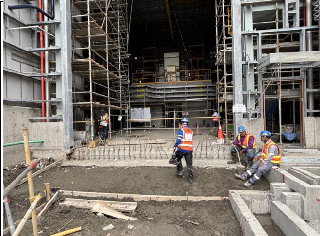
主發電設備工程 廠房結構
