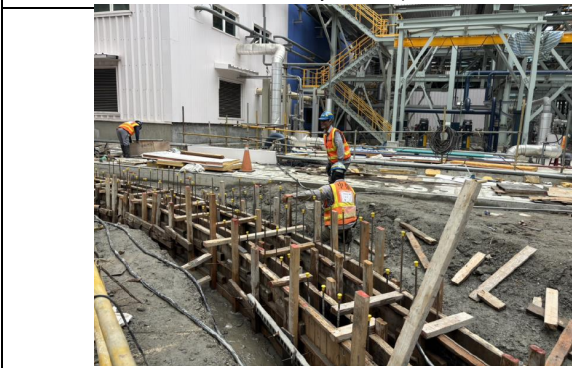
主發電設備工程 排水系統
