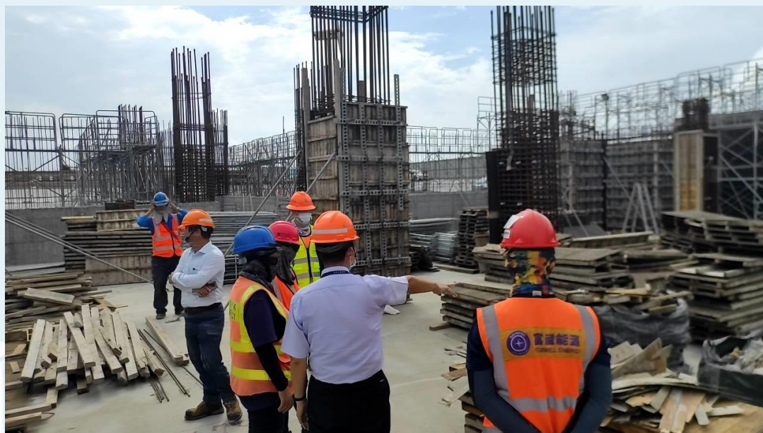
於工程場址進行工安查核
