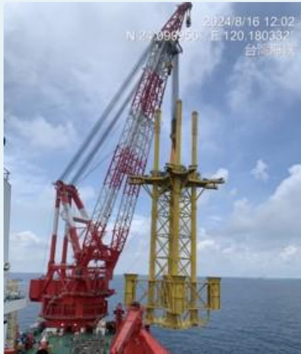
鋼管樁打設-HPPT(模架)安裝作業
