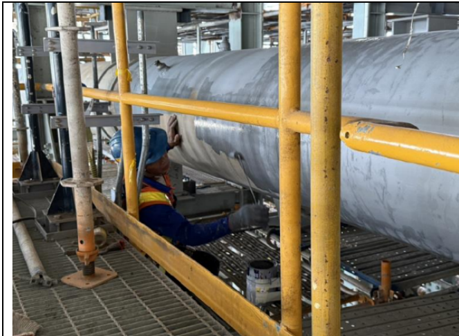
主發電設備工程 Unit 3 HRSG 配管
