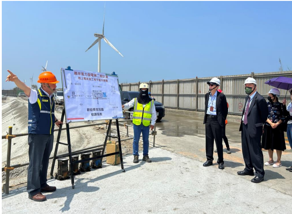
林廠長明成說明陸上電氣室工程
